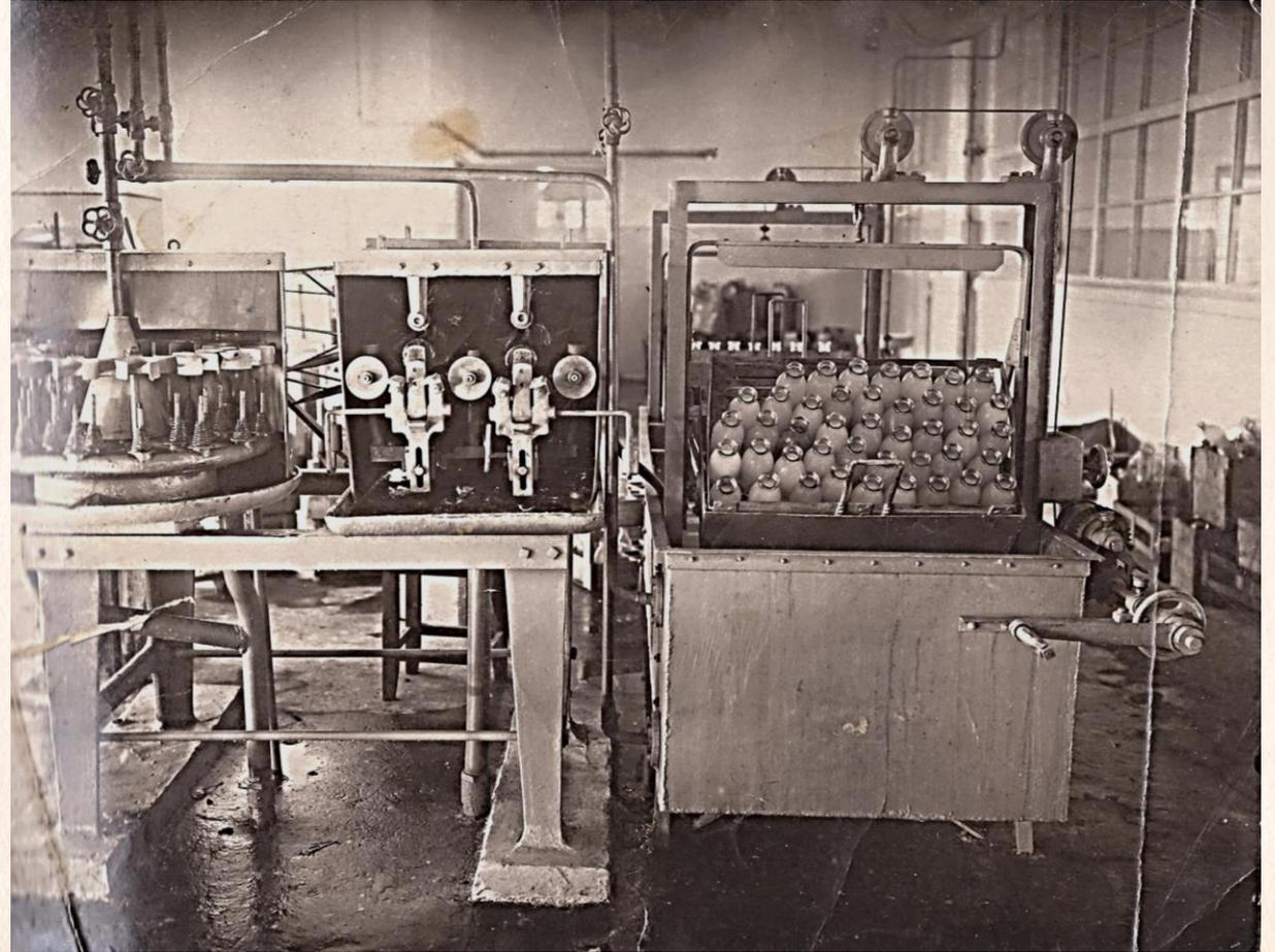
Бутыльно-моечная щеточная машина БМЩ-1
